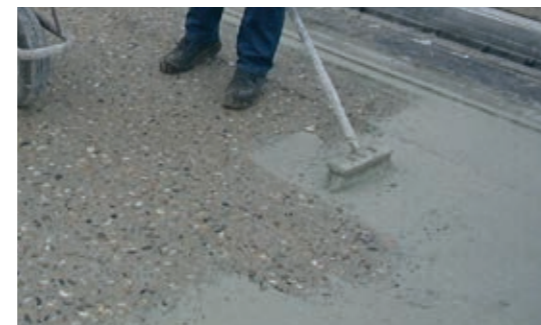
2. Einbürsten der Haftbrücke Nafufill HB
