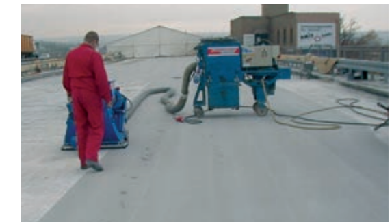
1. Oberflächenvorbereitung des eingebauten Nafufill KM 130 / KM 180 durch Blastrac-Strahlen
