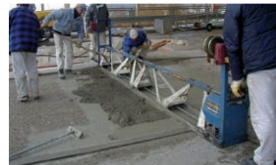
3. Einbau des Betonersatzsystems Nafufill KM 130 oder Nafufill KM 180
