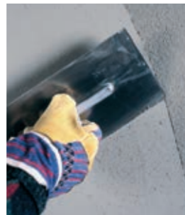
2. Beschichtung (Hand- oder Spritzverarbeitung) Zentrifix F 92 3.200 g/m 2
