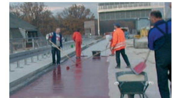
2. Je nach Untergrunderfordernis Aufbringung einer Grundierung, Versiegelung oder Kratzspachtelung mit MC-DUR LF 480 (inkl. Absandung)
