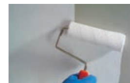
2. Erste Deckschicht EmceColor-flex E 280 ml/m 2
