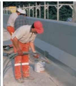
2. Beschichtung (Hand- oder Spritzverarbeitung) Zentrifix F 92 3.200 g/m 2
