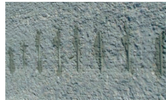
1. Korrosionsschutz der freiliegenden Bewehrung mit Zentrifix KMH
