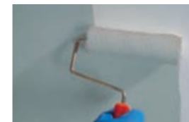
3. Zweite Deckschicht EmceColor-flex S 280 ml/m 2
